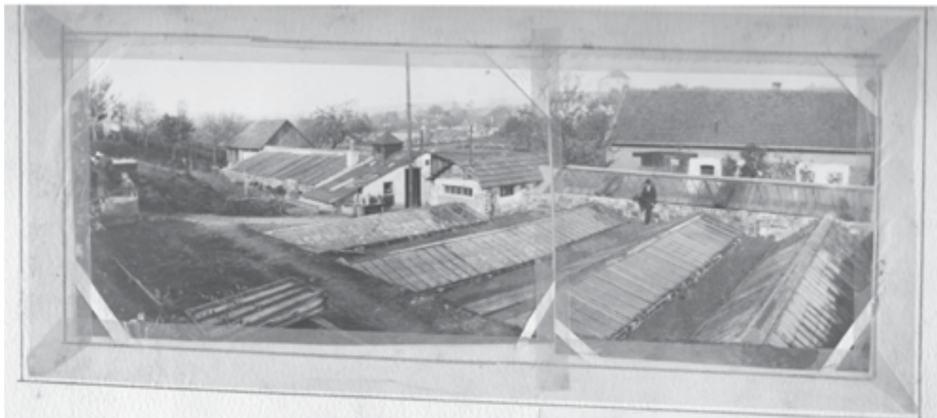
Pohled na areál (1946)
